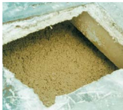
3. Otwór technologiczny do wdmuchiwania granulatu
